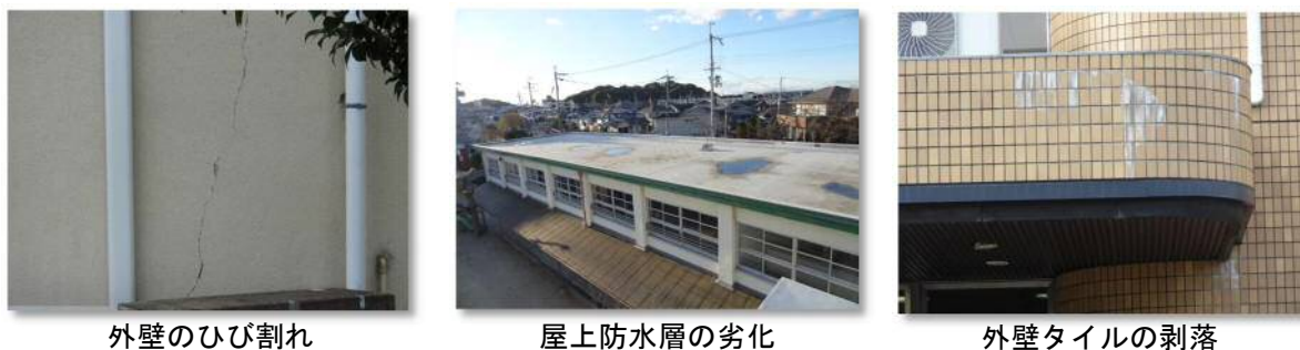
図一 公共施設の劣化状況
