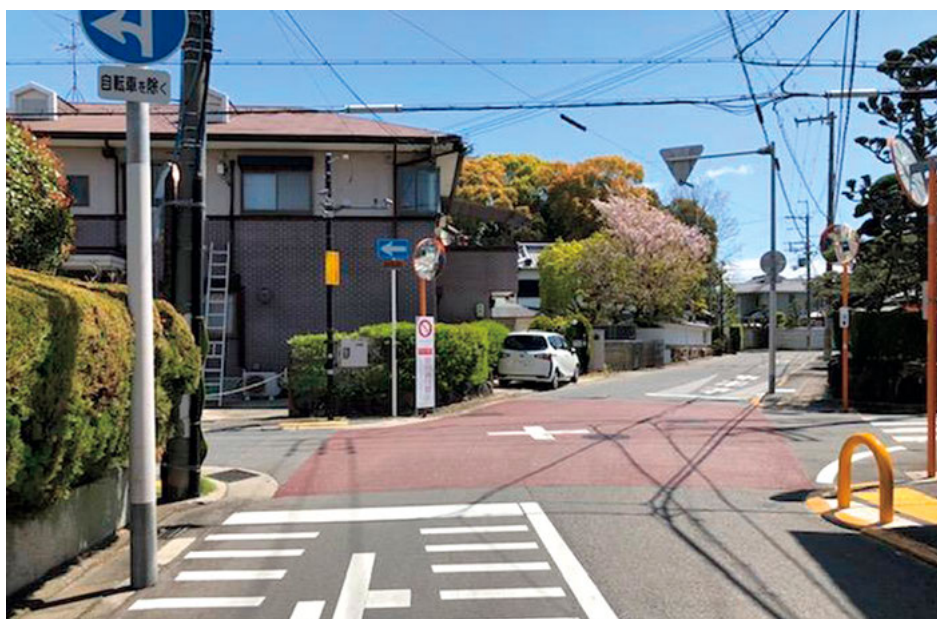
交差点カラー舗装
