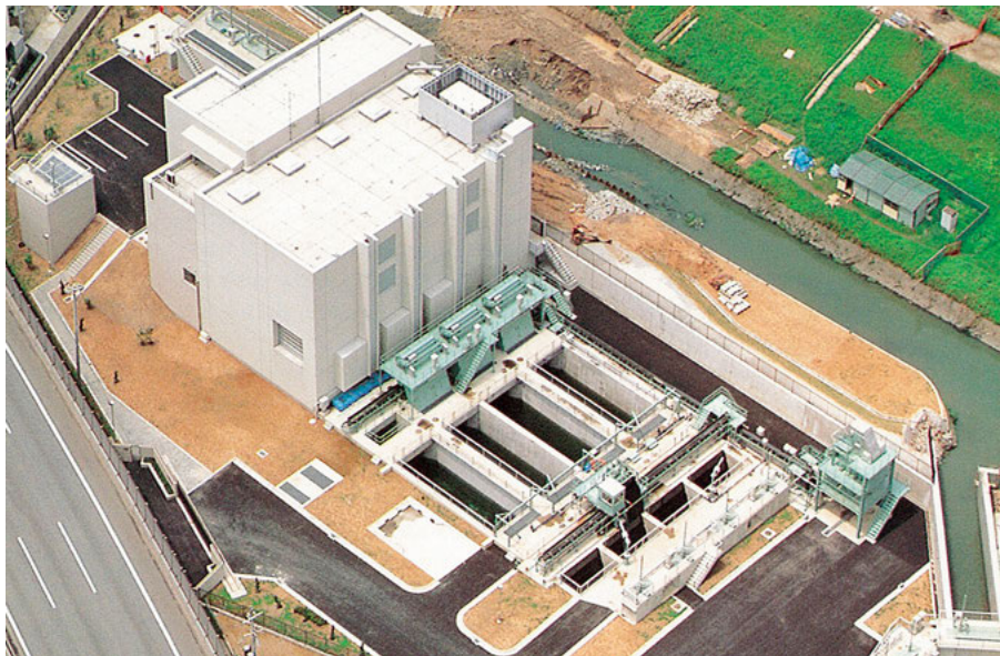
小山雨水ポンプ場
