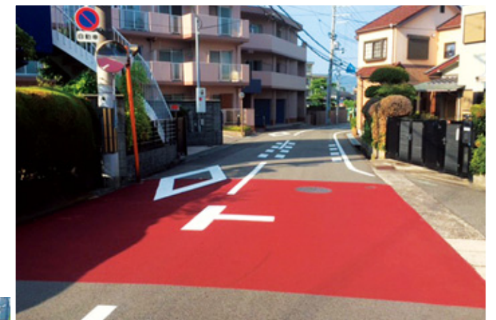
交差点カラー舗装
