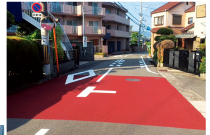
交差点カラー舗装
