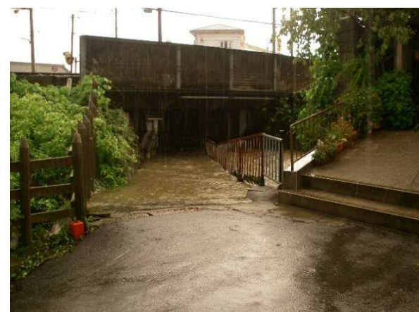
大雨の時の冠水状況（近鉄高架下）
