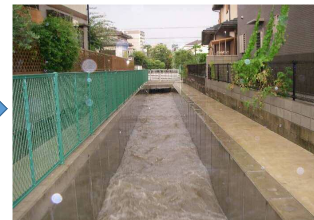
付近の水路改修後、雨天時の状況
