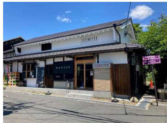
古民家を改修した施設 (MONZEN)
