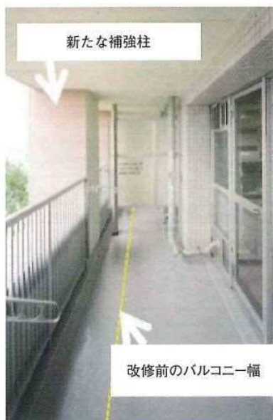
平成 25 年法改正により耐震改修計画の認定対象になる改修工法の例
