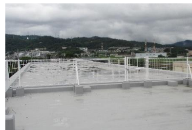
道明寺東小学校屋上防水
