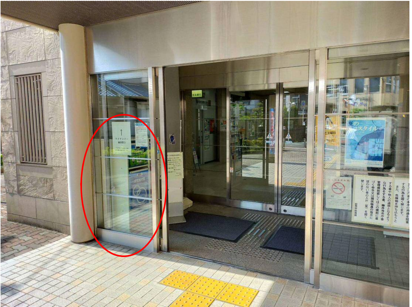
(庁舎外側からの写真)
