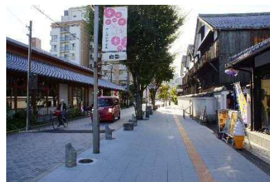
歩道を拡幅し、歩行者の回遊性を高め地域の賑わいを高めるよう整備
