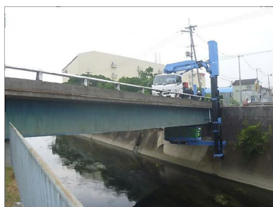
(例) 写真-点検状況 1 (橋梁点検車)
