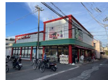
延床面積500㎡超の店舗の例 （食品館アプロ 道明寺店 800㎡程度）
