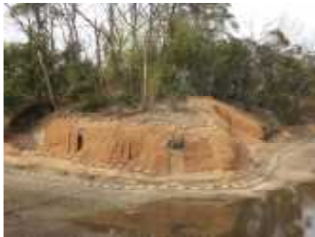
峯ヶ塚古墳 墳丘整備
